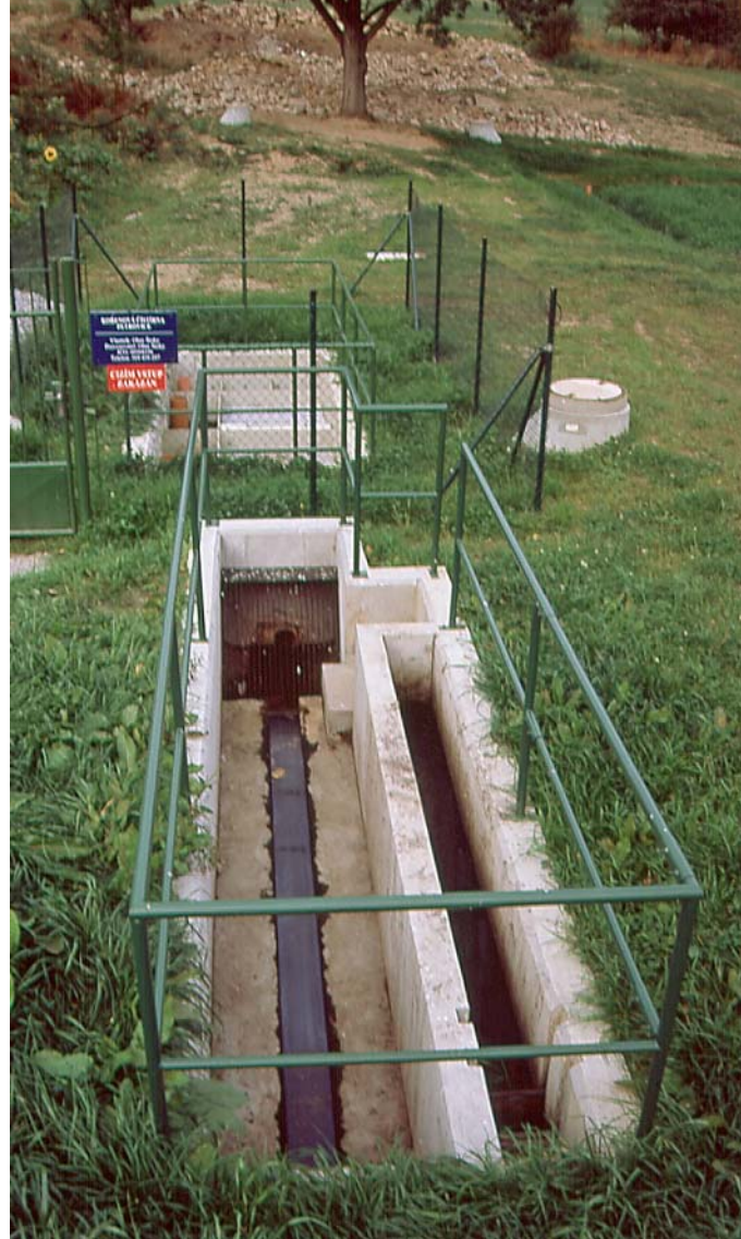
Foto 7 Předčištění (lapák písku, česle a šterbinová nádrž) na KČOV Petrovice u Havlíčkova Brodu. Foto J. Vymazal.
