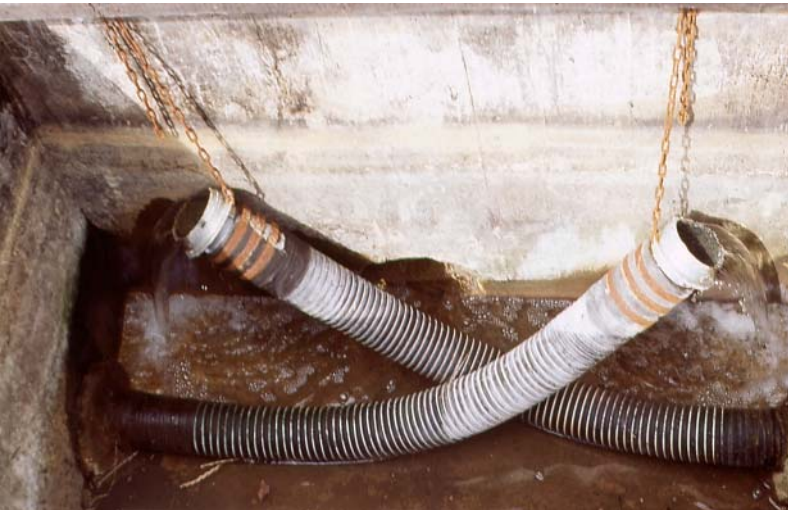
Foto 10 Regule výšky vodní hladiny ve filtračním poli pomocí flexibilních hadic zavěšených na řetízcích na KČOV Spálené Poříčí. Foto J. Vymazal.
